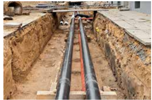
Ungesicherte Baugrube – kein Entkommen
