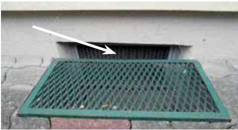
Ungesicherter Lichtschacht – Absturzgefahr
