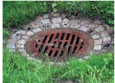
Abfluss mit kleinen Öffnungsschlitzen – igelsicher
